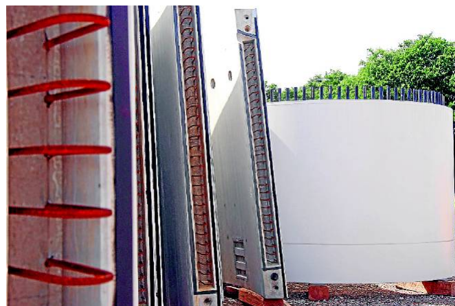
Die unteren, breiteren Betonringe des Turms werden als Halbschalen aus Süddeutschland geliefert. Ein kompletter Ring ist gut vier Meter hoch und bis zu 40 Tonnen schwer.
