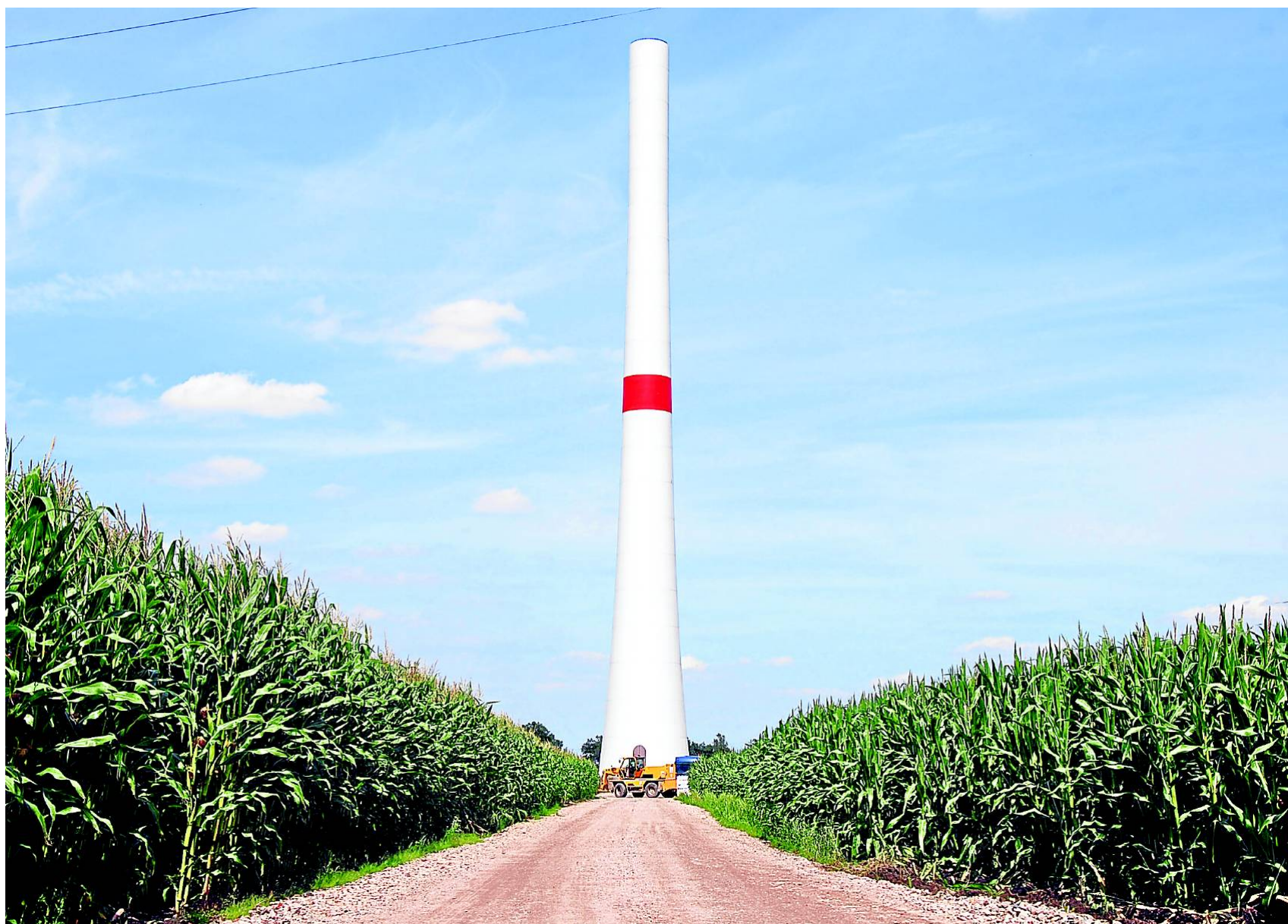
Einer der vier Betontürme im Strönfeld steht bereits: Die fertige Windkraftanlage, also der Turm inklusive Gondel und Rotorblätter, wird eine Höhe von knapp unter 200 Metern erreichen. Fotos: Dennis Stein
